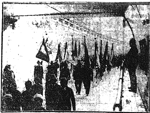
Otwarcie tunelu pod Skaldą.
