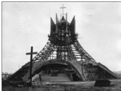
Proboszcz jest zafascynowany pięknem konstrukcji. „Gdzie my mieliśmy oczy?” - napisał w kronice parafialnej. Najchętniej jeszcze teraz zmieniliby całość budowli, zdejmując pokrycie dachowe i ukazując częstochowską wieżę Eiffla. (Fotografia z okresu budowy kościoła)
