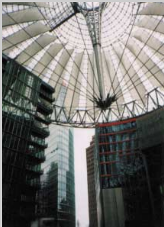
fot. S. Burszewski „Sony Center”
